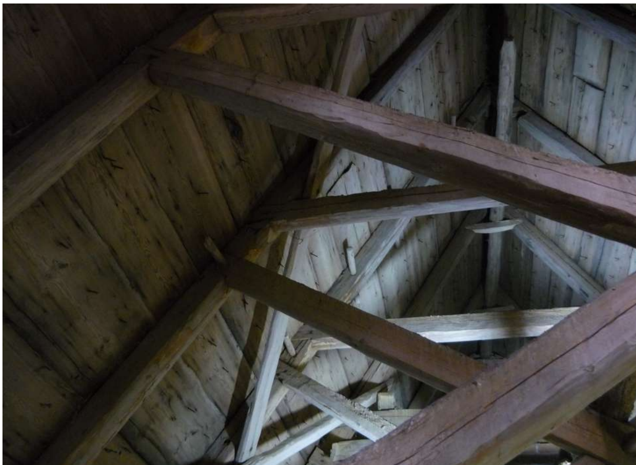
Kuvassa on Akaan kivisakastin kuusesta veistettyjä, hyväkuntoisia kattorakenteita. Selkäpuissa erottuvia tappeja on ilmeisesti käytetty myös tikkaina. Kuva: arkkitehtitoimisto Livady
