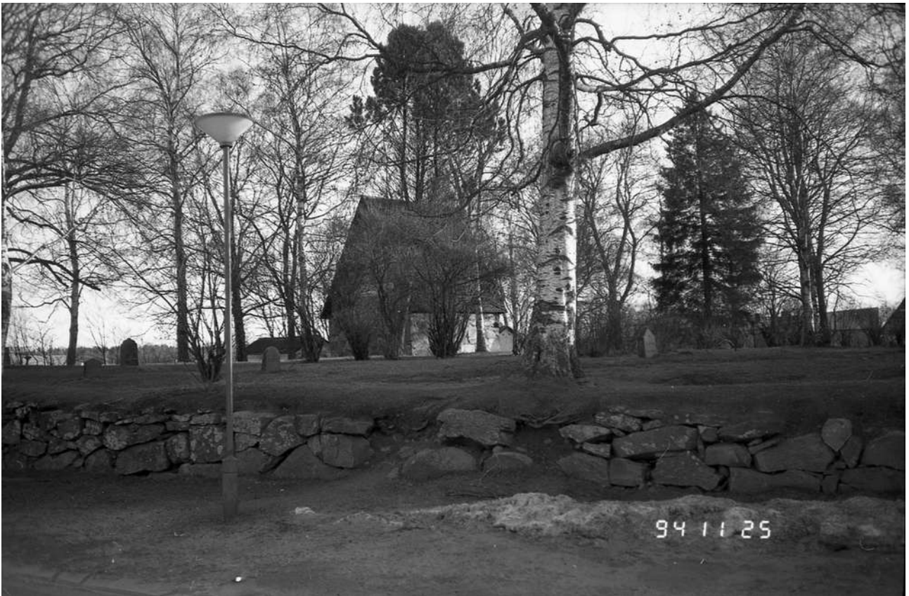
Pohjoispuolen kulku hautausmaalle aiheutti vuosien aikana aidan lakoamisen. Kuva: Markus Hiekkänen 25.11.1994/Akaan seurakunta.
